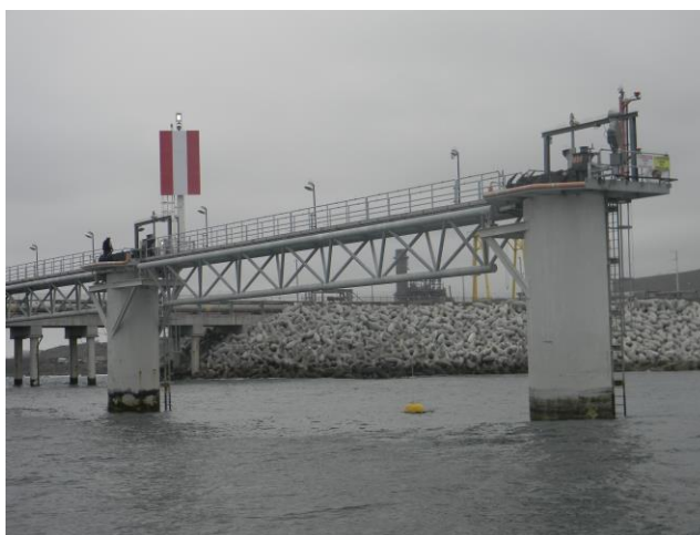
Figura 3.- Boya amarrada entre los pilares de la terminal marítima ECA.
