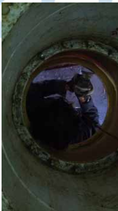
Fig. 6 – Empleando la esmeriladora angular en la parte inferior del nicho.
