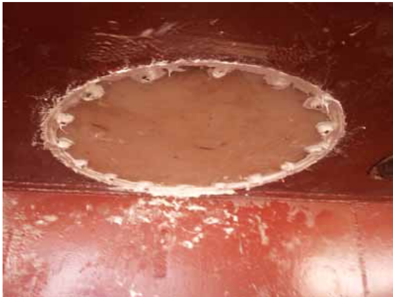
Fig. 8 – Ventana acústica colocada nuevamente luego del mantenimiento.
