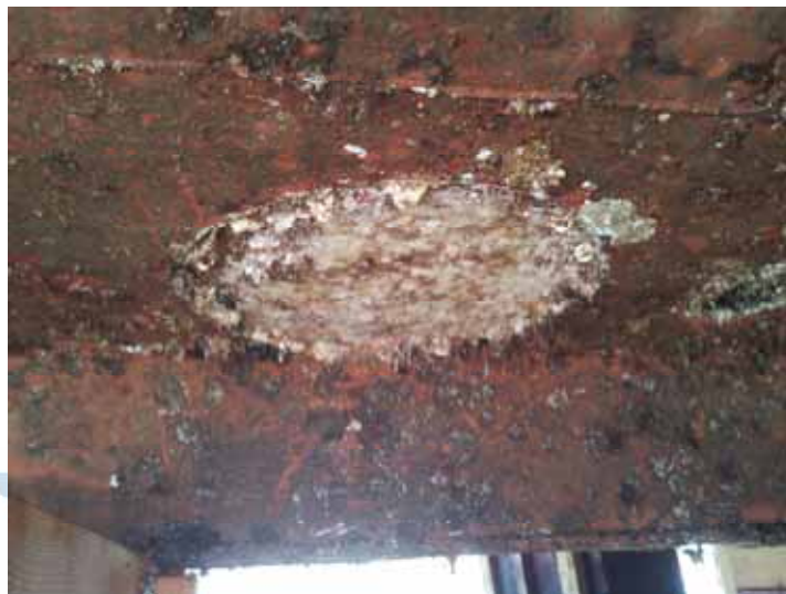
Fig. 5 – Ventana acústica del nicho del ADCP antes del mantenimiento.
