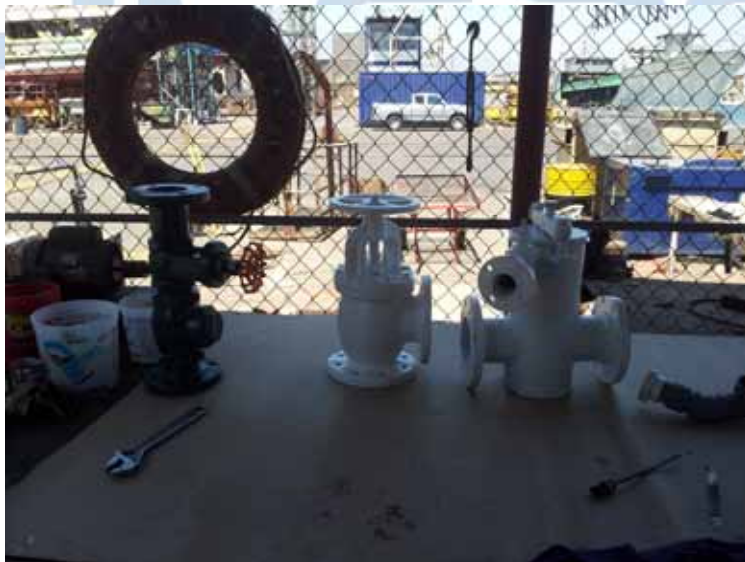
Fig. 27 – Algunas de las válvulas de fondo luego del mantenimiento completo.
