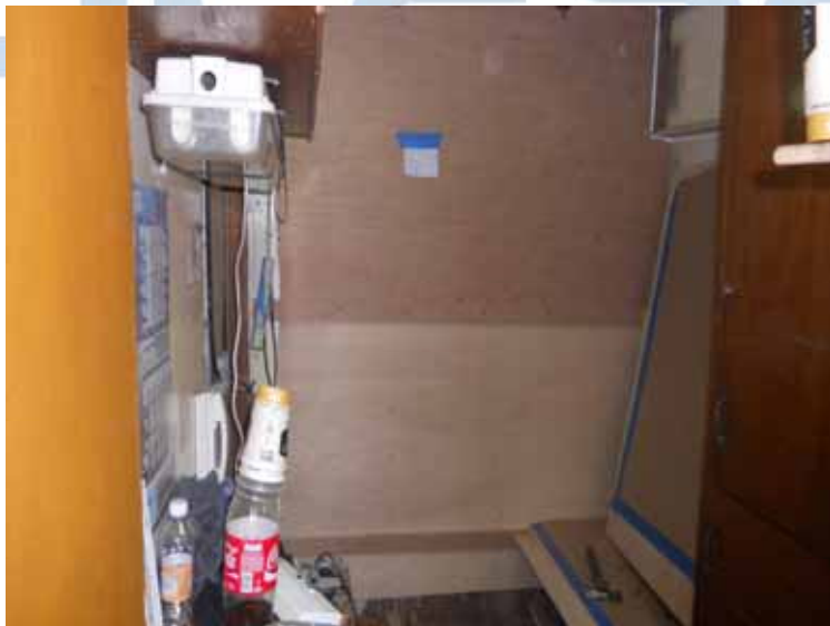
Fig. 49 – Avance del rearmado de carpintería de camarote de oficiales de máquinas.
