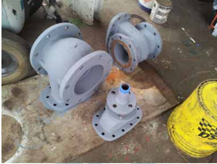
Fig. 15 – Parte de las válvulas de fondo, desarmadas, revisadas y con pintura base secando.
