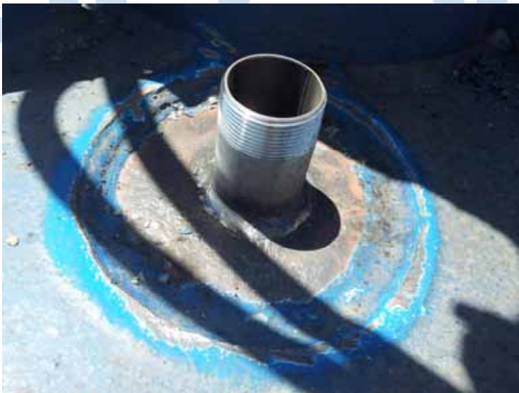
Fig. 25 – Nueva tubería en línea de sonda de tanque de diesel #7 estribor.
