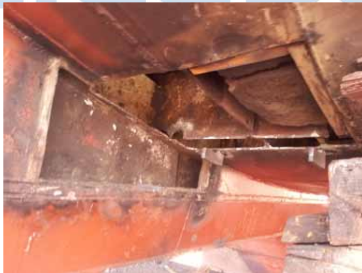
Fig. 41 – Corte de placa en área de máquinas, terminado. Se observa corte adicional cerca de la quilla.
