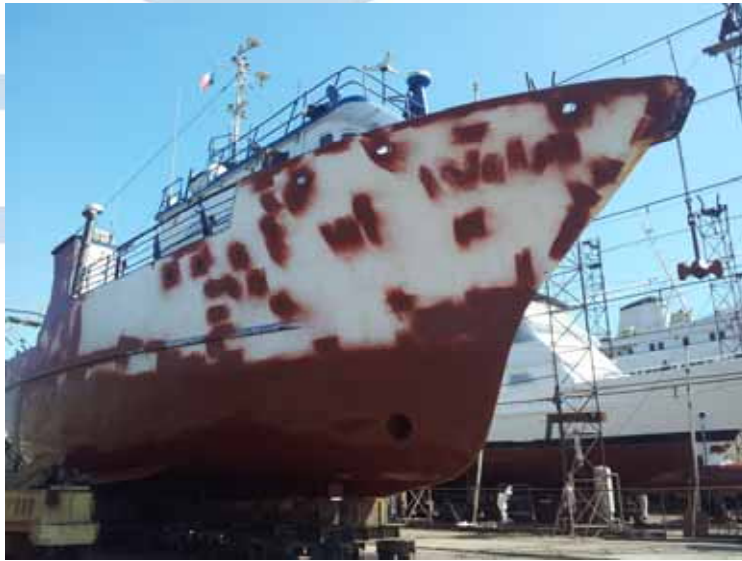
Fig. 12 – Terminada la aplicación de la primera capa de pintura base en costado de estribor.
