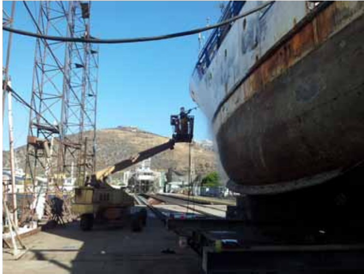
Fig. 13 – Remoción de pintura de casco con agua a presión en banda de babor.
