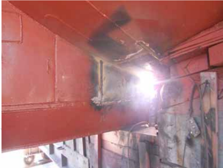
Fig. 48 – Soldadura de placa nueva en área de máquinas.
