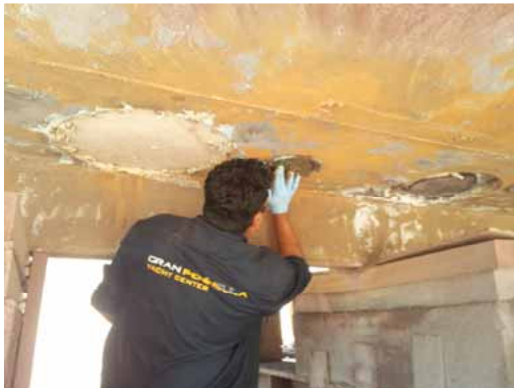
Fig. 16 – Aplicando grasa al área expuesta de transductores antes de pintar banda de babor, para evitar que la pintura los afecte.
