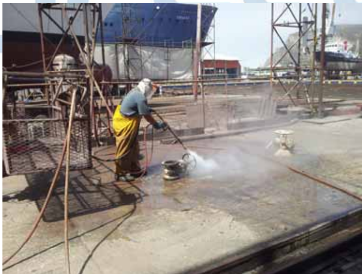
Fig. 14 – Limpieza con agua a presión de algunas de las válvulas de fondo.
