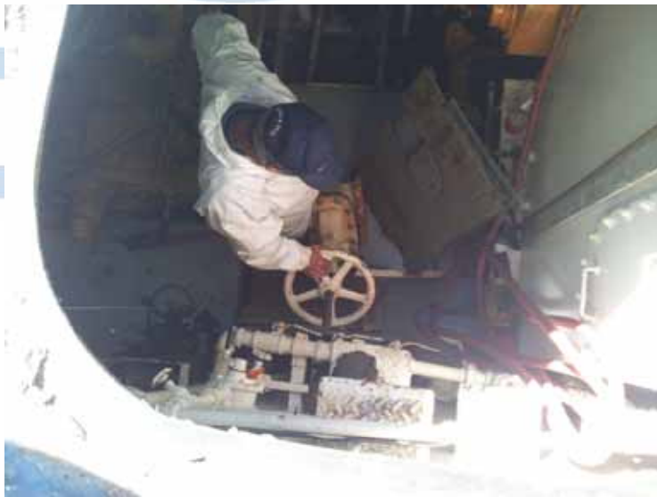
Fig. 8 – Remoción de las válvulas de fondo del buque en proceso.
