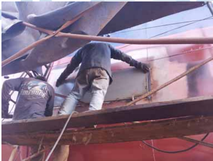
Fig. 43 – Presentando la placa nueva para renovación en costado de estribor.
