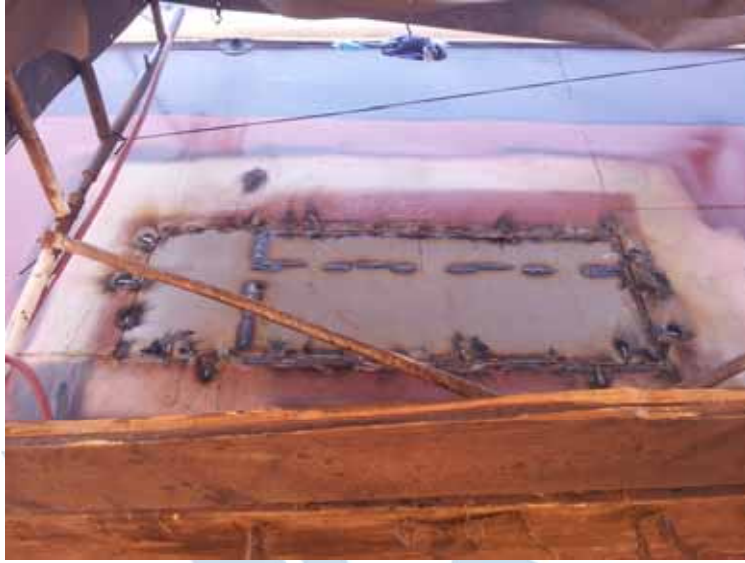
Fig. 44 – Avance de soldadura de placa de costado estribor.
