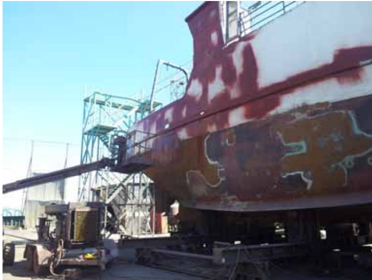
Fig. 7 – Se inicia la aplicación de pintura base roja (primera capa) en el casco.
