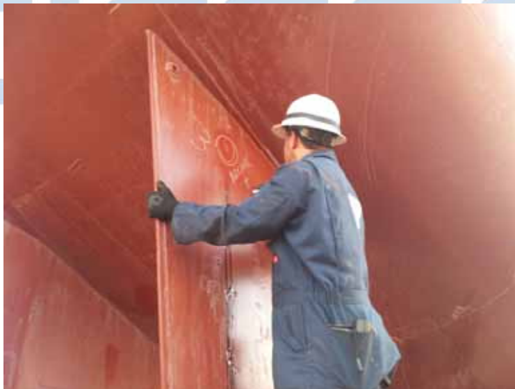
Fig. 22 – Inspector de ABS marcando reparación a realizar en estabilizador de popa de la banda de estribor.
