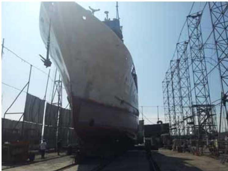
Fig. 33 – Aplicada capa de base color blanco a obra muerta, costado de babor.
