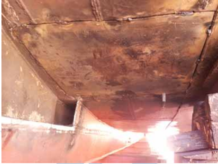
Fig. 46 – Placa nueva en área de máquinas, mostrando los primeros puntos de soldadura.
