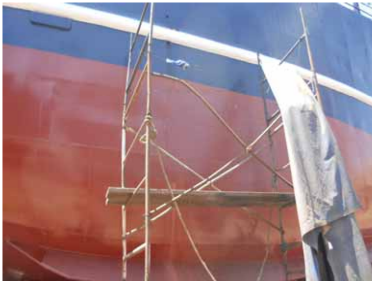
Fig. 47 – Terminado reemplazo de placa en costado de estribor.
