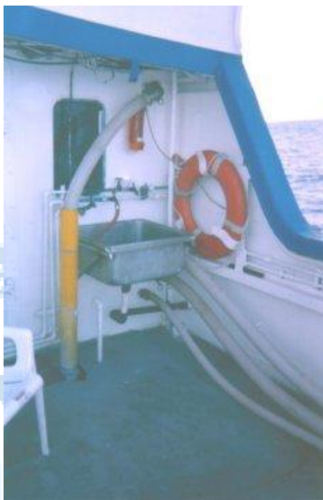
Foto 15. Para la instalación interna de la bomba de succión fué necesario pasar la manguera (que sale de la caja metálica en el cuarto de máquinas) por la cubierta de popa, para lo cual se instaló una protección metálica (color amarillo).
