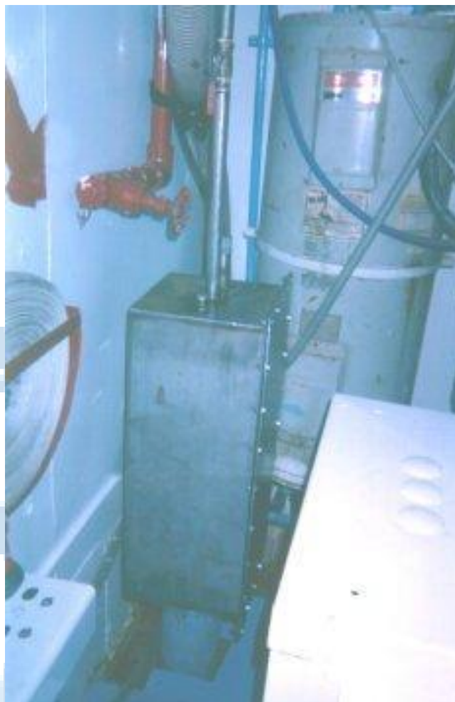
Foto 12. Instalación de la bomba de succión dentro de una caja metálica de acero inoxidable, en el cuarto de máquinas del B/O Francisco de Ulloa.
